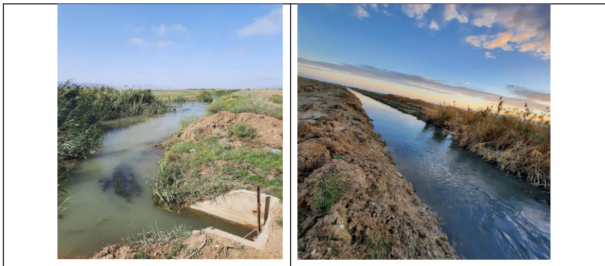
Рис. 6. Коллектор К-6 около юго-западной оконечности оз. Большое Турали до (левый снимок) и после (правый снимок) расчистки в сентябре – октябре 2022 г.
